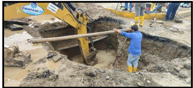
CDLA. FEBRES CORDERO: AV. JOFFRE LIMA Y 2DA. TRANV. Reparación de fugas
