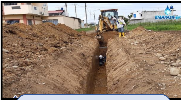
CDLA. DEL CHOFER: C. 12AVA ENTRE FLORESTA Y GUILLERMINA UNDA. Ampliación de 200mm de Red Principal de Alcantarillado
