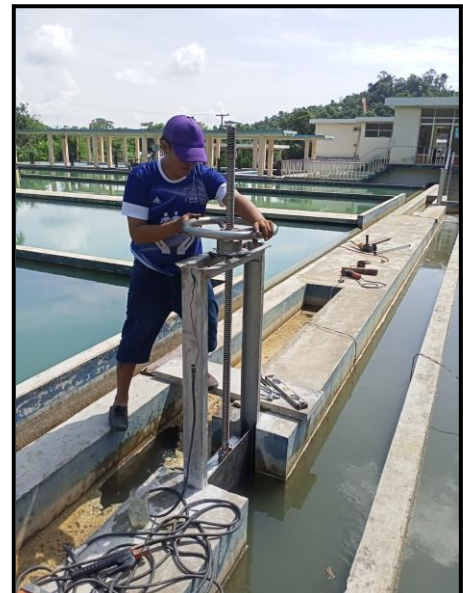
CAMBIO DE COMPUERTAS
