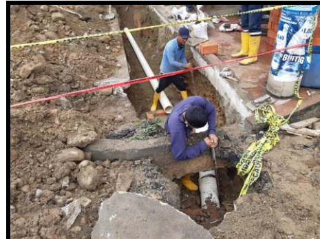
P. LA AVANZADA: SECTOR COMERCIAL Ampliación de redes terciarias de alcantarillado Más de 30 familias beneficiadas
