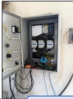
BOMBA Y TABLERO DE CONTROL
