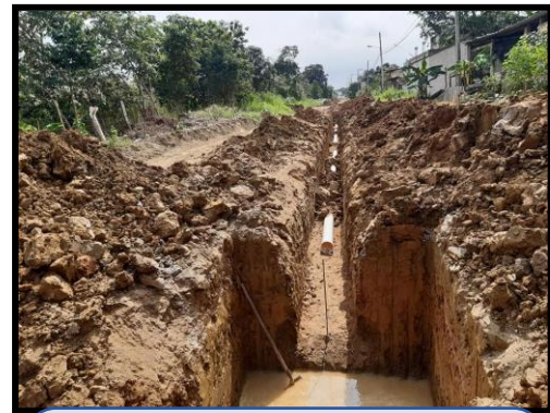
P. BELLAVISTA: B. EL CISNE - C. ANTONIO JOSÉ DE SUCRE Ampliación de 240m de Red Principal de AA.SS.
