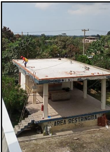
IMPERMEABILIZACIÓN DE LAS CUBIERTAS DE LAS INSTALACIONES DE LA PLANTA DE AA.PP.
