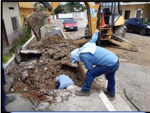
B. 29 DE NOVIEMBRE: C. MARUJA RAMÍREZ Y CHIMBORAZO Reparación de fuga
