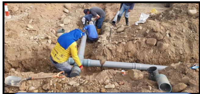
CDLA. LOS LAURELES: C. 1RA e/ C. ELOY ALFARO y Av. MANUELITA SÁENZ Ampliación de 140ml de red principal de AA.PP. de 160mm Más de 80 familias y Terminal Terrestre del Cantón Santa Rosa beneficiados
