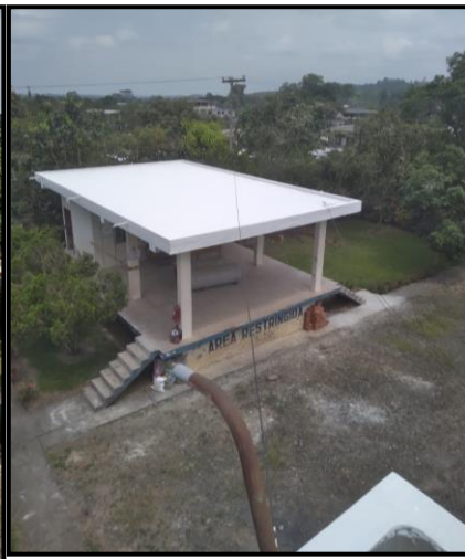
IMPERMEABILIZACIÓN DE LAS CUBIERTAS DE LAS INSTALACIONES DE LA PLANTA DE AA.PP.
