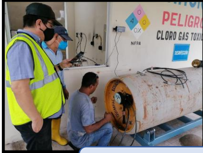
ADQUISICIÓN E INSTALACIÓN DE UN NUEVO SISTEMA DE CLORO GAS
