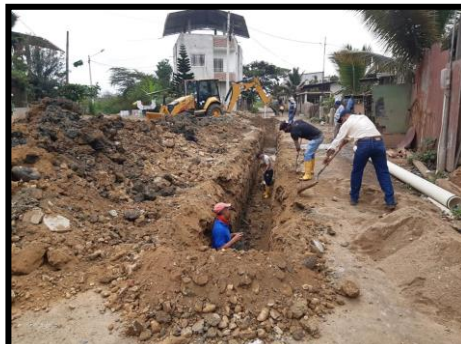
BARRIO CRISTO DEL CONSUELO: C/ PEATONAL 1 Y 2, CALLEJÓN S/N Y MACHALA AMPLIACIÓN DE REDES PRINCIPALES, SECUNDARIAS Y TERCIARIAS DE ALCANTARILLADO: Instalación de 300m de tubería de 225mm, 200m con tubería de 175mm, 5 colectores principales y 30 cajas de revisión domiciliaria.
