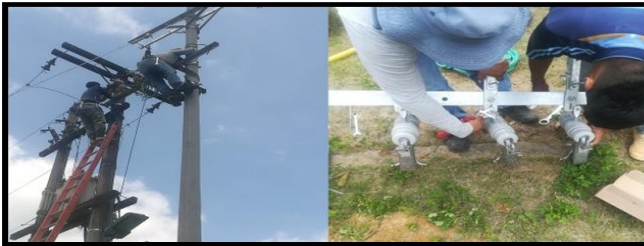
CAMBIO DE LA ACOMETIDA PRINCIPAL QUE DOTA DE ENERGÍA AL SISTEMA ELÉCTRICO
