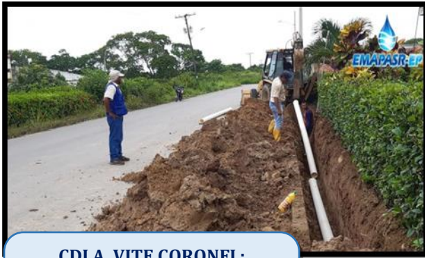
CDLA. VITE CORONEL: Av. Sixto Durán e/8ava y 9na Instalación de 70 m de tubería perfilada PVC de 175 mm
