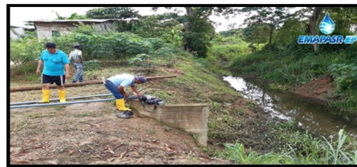
LOT. TIERRA SANTA Re instalación de la red de agua potable
