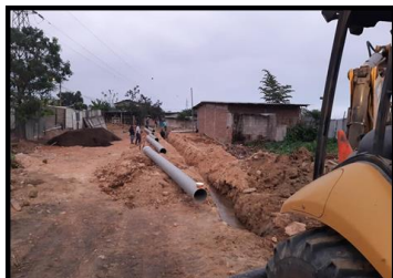
BARRIO CRISTO DEL CONSUELO: C/3°, entre Cuenca y Av. D Ampliación de 70mm de tubería de 315mm
