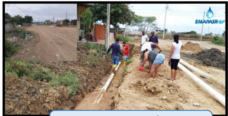
LOT. NUEVO PAÍS: Ampliación de Red de Alcantarillado
