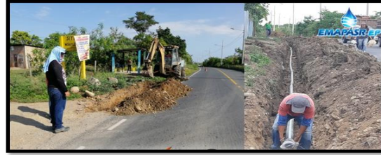
PARROQUIA SAN FRANCISCO DE JUMÓN Instalación de aproximadamente 1 km de tubería de 90 mm
