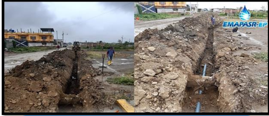
CDLA. LAS MORENITAS - NUEVO PAÍS Ampliación de 200ml de tubería de 90mm y 63mm
