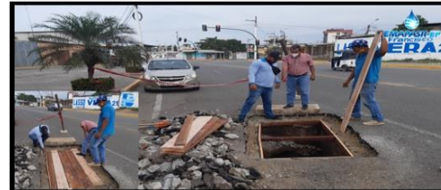
BARRIO ORITO: Calle Manuelita Sáenz y San Vicente. Construcción de la loseta y tapas de hormigón
