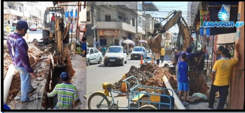
CASCO CENTRAL: Eloy Alfaro y Cuenca Asentamiento de la red antigua de cemento
