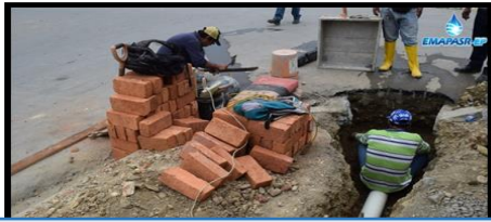
BARRIO TNTE. HUGO ORTIZ: Calle Francisco Rivera y Vicente Betancourt. Reconstrucción de cajas domiciliarias
