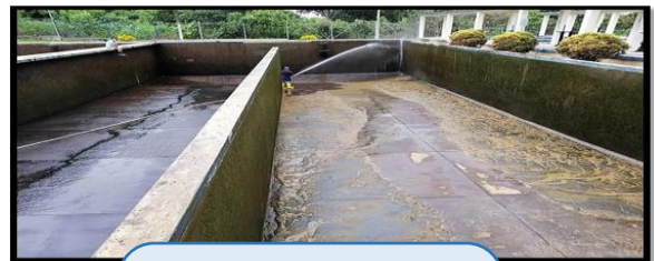
LIMPIEZA DE LOS FLOCULADORES Y SEDIMENTADORES de la Planta de Tratamiento de Agua Potable N°1
