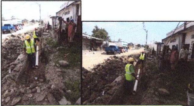
CONSTRUCCIÓN DE RED TERCIARIA DE 175 mm EN CALLE SAN VICENTE E/ MANUEL PESANTEZ Y ZOILA ARAUZ- BARRIO ATAHUALPA
