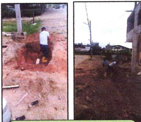
AMPLIACIÓN DE RED SECUNDARIA Y TERCIARIA EN SECTOR SARA CAVERO, CALLE 1º DE ENERO Y VÍA A LOS CEIBOS; Y CONSTRUCCIÓN DE CAJA DOMICILIARIA
