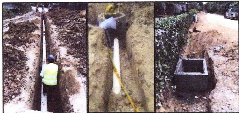
AMPLIACIÓN DE 200m DE TIRANTES Y RED TERCIARIA EN EL SECTOR EL SAUCE - SITIO SAN AGUSTÍN (BENEFICIA 10 FAMILIAS)
