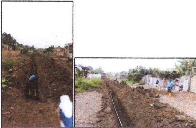
AMPLIACIÓN DE 110 m DE RED DE AA-PP CON TUBERÍA DE 63mm EN CALLE EDMUNDO CHIRIBOGA Y TERESA ARCA YA (BENEFICIA 30 FAMILIAS)
