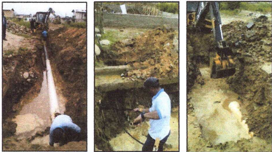
AMPLIACIÓN DE LA RED PRINCIPAL DE AA-PP CON TUBERÍA DE 315mm BARRIO VIRGEN DEL CISNE
