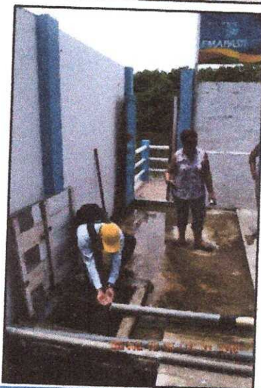
CONSTRUCCIÓN DE POZO PROFUNDO DE AGUA POTABLE EN LA PARROQUIA JAMBELÍ (BENEFICIADOS 900 USUARIOS)
